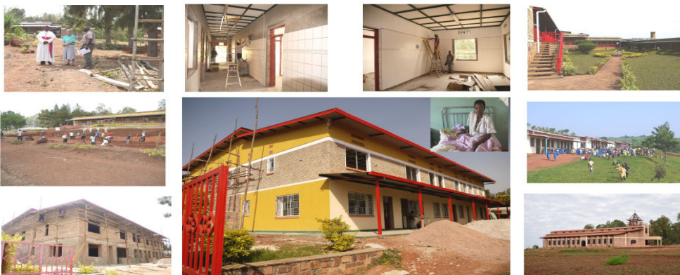
Le varie fasi della costruzione della nuova maternità - Il Centro di Sanità P.Tiziano - Il Gruppo Scolastico Aurora Giovanni La Chiesa Parrocchiale di Munyaga dedicata a <Gesù Misericordioso> realizzata dalla Diocesi di Kibungo
